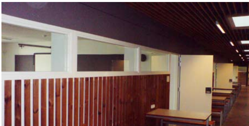
Dagsljus till skolkorridoren förs in dels via fönster till klassrummen och dels via takfönster. Takfönstren solavskärmas för att inte få in solvärmen, se nästa bild. Hjörning, Danmark.
