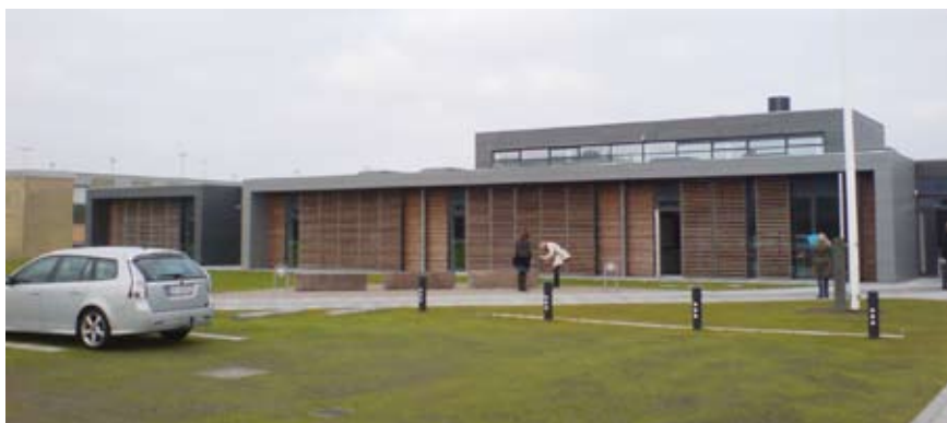
Södervägg i passivhusskola, Hjörning, Danmark.
