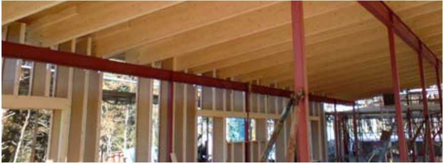
Förskola i Alingsås. Lättreglar för ytterväggar och stålkonstruktion för stommen.
