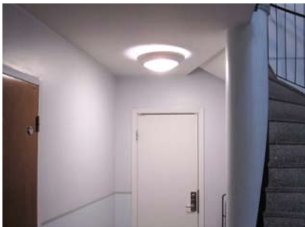
LED armatur för trapphus. Finns även med närvaroavkänning och tänd/släck- eller min/max-funktion för att slavstyra armaturer utan sensor. Motsvarar 22 W kompaktlysrör. Dimbar till 10% via driftspänning. Källa: Energisystem, Nyköping.
