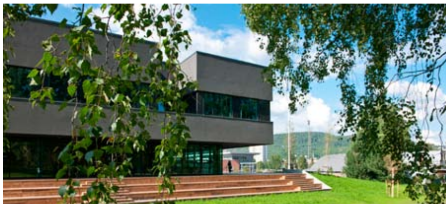
Marienlysts skola, 4 mil väst om Oslo. Fasad mot nordost. Juni 2010. Foto: FutureBuilt/Espen Gees.
