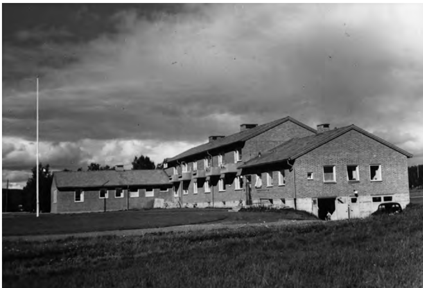
BERG (Jämtlands län) I denna kommunala byggnad i Svenstavik fanns på 1950-talet bland annat kommunalkontor, arbetsförmedling, tandläkare och förlossningsklinik. KÄLLA: SVERIGES KOMMUNER OCH LANDSTINGS ARKIV, FRÅN KOMMUNERNA 1955
