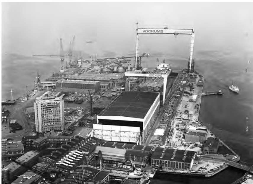
MALMÖ Flygfoto över Kockums med huvudkontoret, bockkranarna och hallarna. FOTO: KOCKUMS MEKANISKA VERKSTADS AB/MALMÖ STADSARKIV
